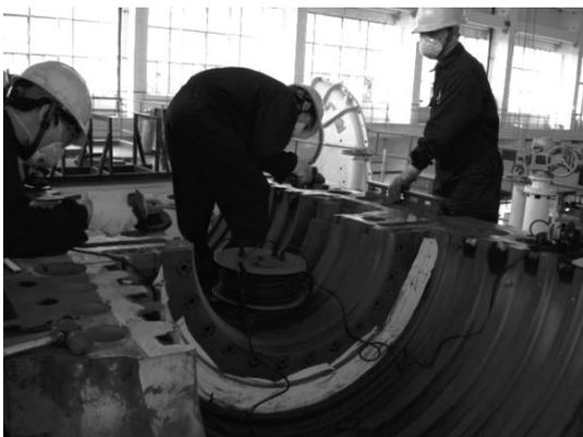
图2 上海闸北电厂汽缸平面再制造
